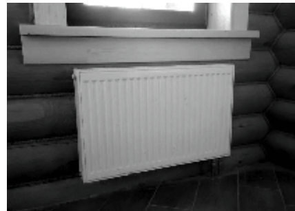
При прихованому прокладанні труби можна закрити, наприклад, стіновими дерев'яними панелями
