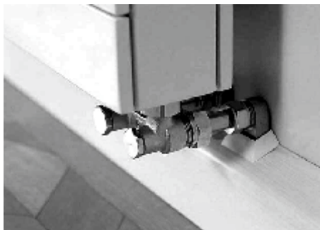
Декорування трубопроводу опалення коробом
