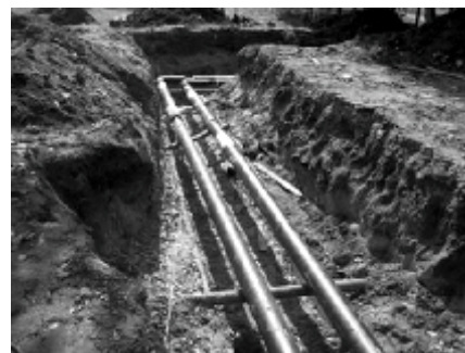
Безканальне прокладання опалювальних труб
