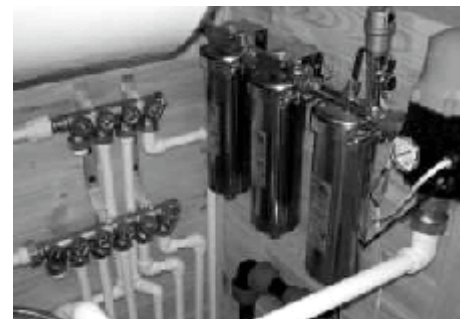
Монтаж насосів в системі водопостачання
