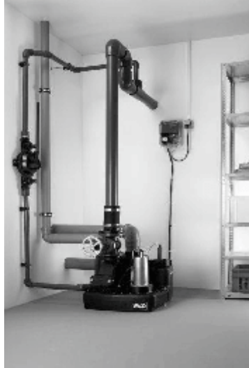
Приклад прокладання трубопроводу вище рівня зворотного підпору
