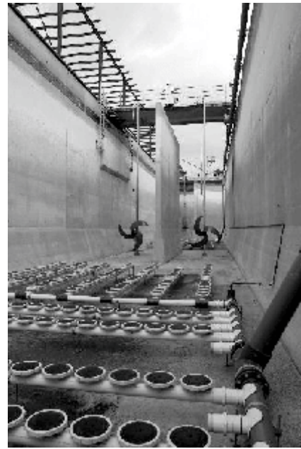
Мішалки та система аерації
