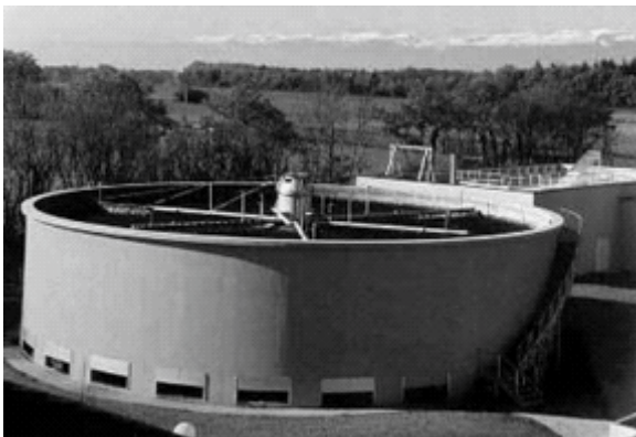
Рис. 6 - Біологічний крапельний фільтр:
